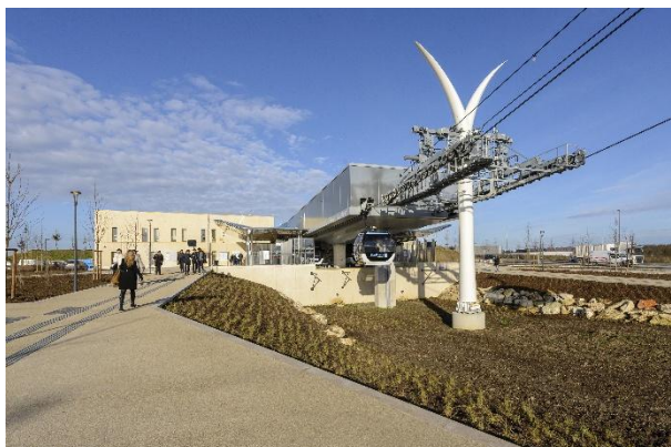
Câbles C1 – Architecte : Atelier Schall – ©Photo : Ecliptique-Laurent Thion
